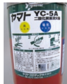
ハロン消火器から入れ替えた二酸化炭素消火器
