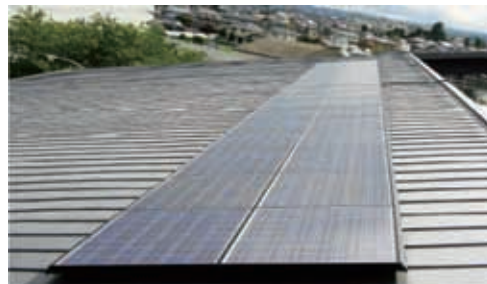
藤枝工場新事務厚生棟に設置した太陽光パネル
