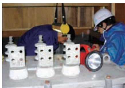
PCB含有試料採取作業
