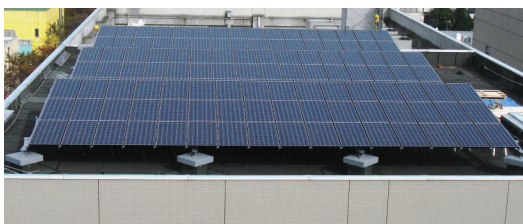
浮間事業所生物試験棟屋上に設置した太陽光パネル
