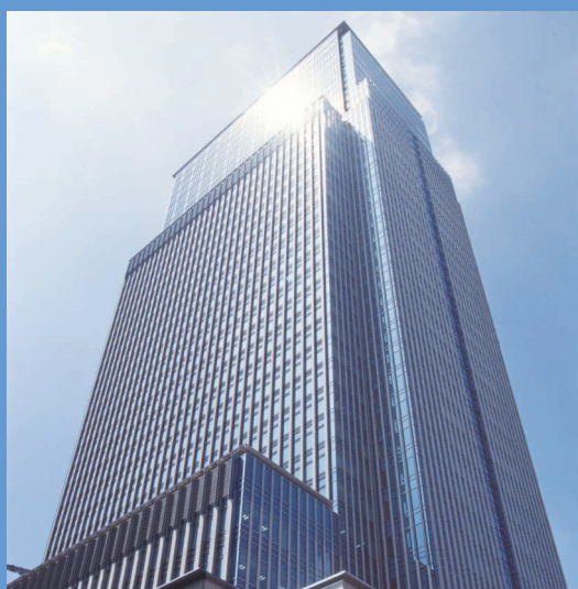
日本橋三井タワー外観（本社フロア15～20F）
