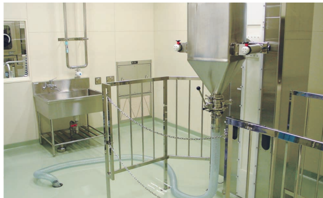
第2製剤治験薬棟製造設備の一部と排水ライン
