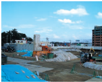
汚染土壌掘削除去工事
