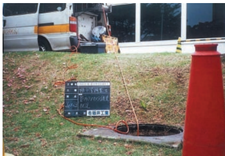
ロボットカメラによる調査状況
