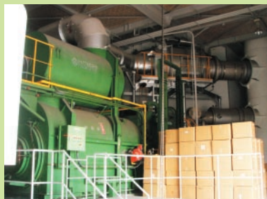
焼却炉撤去前
