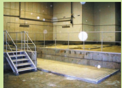
焼却炉撤去後
