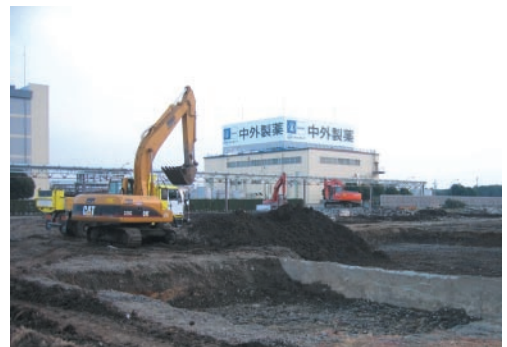
汚染土壌掘削除去工事
