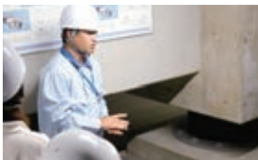
● 免震構造の仕組み(免震ピット)
